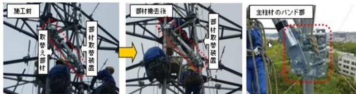
第5-2-21図 小規模鉄塔の部材取替装置による部材取替状況 7)
